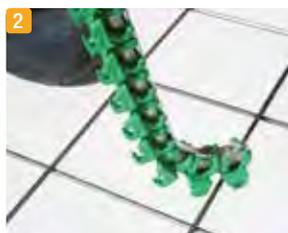
► Colocar el clip sobre el mallazo en la ubicación deseada.
