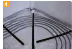
4 Una vez fijadas las guías, procederemos a la instalación del tubo que colocaremos con una separación entre ida y retorno de 10 cm.
