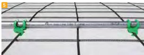
► Una vez colocados todos los clips soporte sobre el mallazo en la distribución deseada, proceder a la instalación del tubo.
