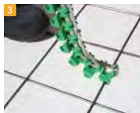
► Encajar el clip en el mallazo en la posición deseada mediante un leve giro.
