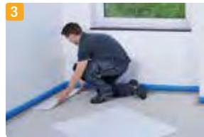
3 Iniciar la colocación de los elementos con curvas en una de las esquinas a testa con el listón de madera.
