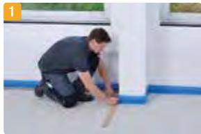
1 Colocación de la banda aislante y listones de madera perimetrales.
