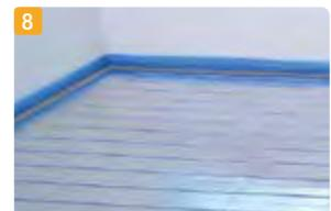
8 Finalizada la instalación realice la prueba de presión y evite el tránsito sobre esta superficie hasta la colocación de su acabado correspondiente.
