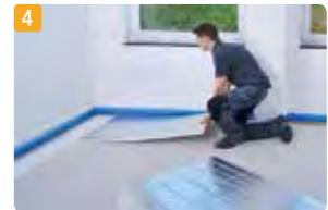
4 Ahora coloque las placas base calefactoras. Si fuera necesario, córtelas por los precortes marcados.
