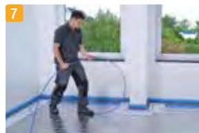
7 Encaje el tubo en las guías evitando tirantes en el tubo.
