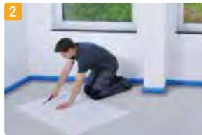
2 Cortar las curvas de la placa base terminal con un cúter.
