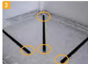
3 Es necesario fijar el conjunto del carril con unos clavos al forjado para evitar que con la fuerza de los tubos se pueda levantar toda la instalación.
