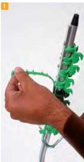
► Fácil carga de los clips Sysclima para mallazo en la herramienta de fijación.
