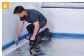
6 Realice la cata de salida de tubos del circuito con una herramienta adecuada. La salida de tubo del circuito debe ser ondulada y no recta.
