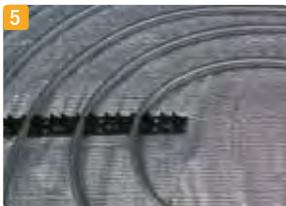
5 A continuación realizaremos la prueba de presión y dejaremos los tubos llenos de agua (si se esperan bajas temperaturas rellenar los tubos con anticongelante).
